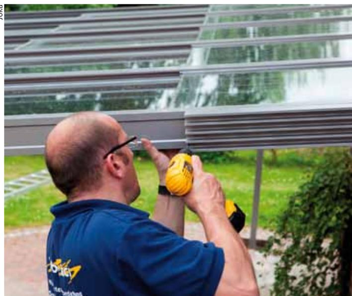
Das System lässt sich recht einfach an der Hauswand oder dem Dachüberstand montieren.
